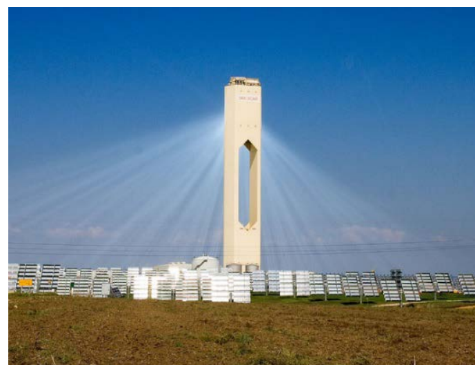
Impianti di potenza
